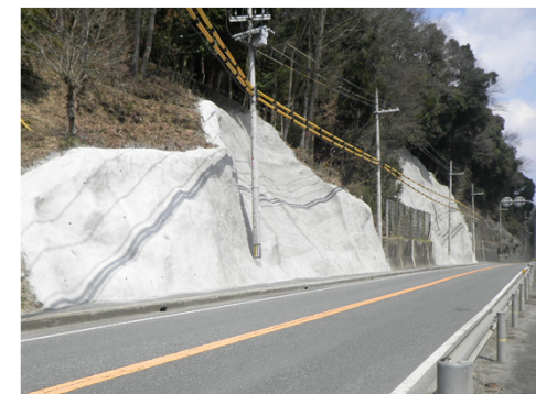
モルタル吹付工(イメージ)
