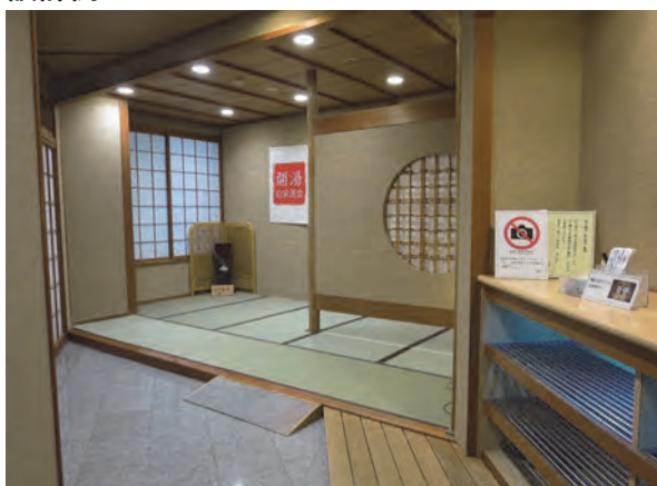
・ スロープで上がり框の段を解消した脱衣室
