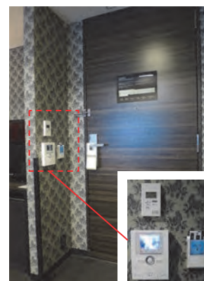
・客室出入口に設けられたカメラ付きインターホン（左）。室内のモニター（右）は床から100cmの高さに設けられている。
