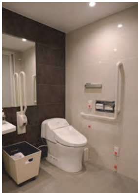
・L型手すりと跳ね上げ式の手すり
