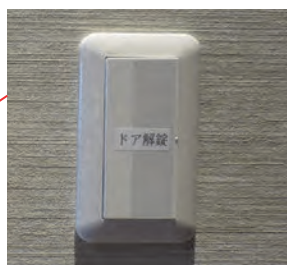
・棒状の取っ手が設けられた開き戸形式の客室出入口及び、戸先のサムターン錠とは逆側に設けられたプッシュボタン方式のドア開錠スイッチ
