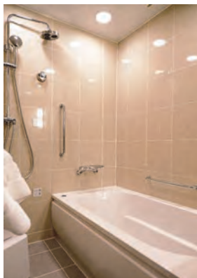
・手すりを設けた浴槽
