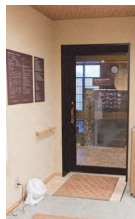
・ 床の一部を下げスノコを設けた、脱衣室から浴室への出入口
