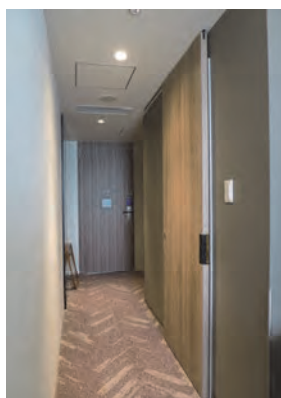
・引き手を彫り込み形式とし、約75cmの有効幅員を確保した便房・浴室等の出入口
