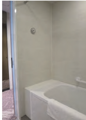
・移乗台、手すりを設けた浴槽
