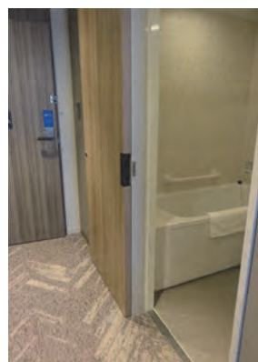
・引き手を彫り込み形式とし、約75cmの有効幅員を確保した便房・浴室等の出入口
