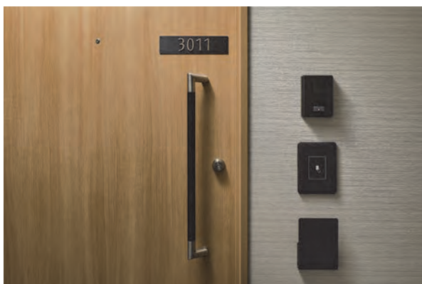
・棒状の取っ手が設けられた開き戸形式の客室出入口
