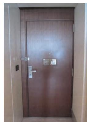
・車椅子使用者の見やすさに配慮した高さに設けられたアイスコープ、避難情報及び避難経路の表示
