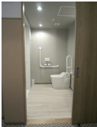
水廻り室出入口 水廻り室出入口は片引き戸となっており、建具下枠の形状をすりつけ状にし、2cm程度の段差を解消している。
