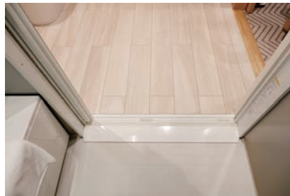
浴室出入口 浴室出入口は、2枚の片引き戸となっており、出入口の前後に高低差はない。
