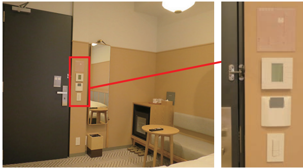
客室出入口まわり (室内側) (上から) 避難経路図、空調機操作盤、カードキー差込口(床から110cm程度)、照明スイッチ
