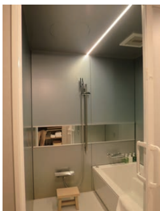
水廻り室出入口 水廻り室出入口は片引き戸となっており、建具下枠の形状をすりつけ状にし、2cm程度の段差を解消している。
