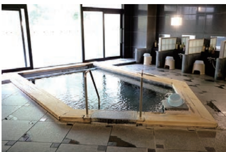
手すりが設けられた浴槽
