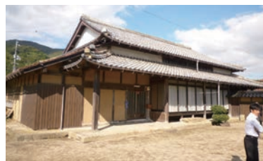
従前の古民家
