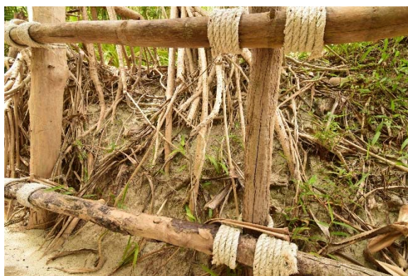
建設中の栈橋（島外側から）
