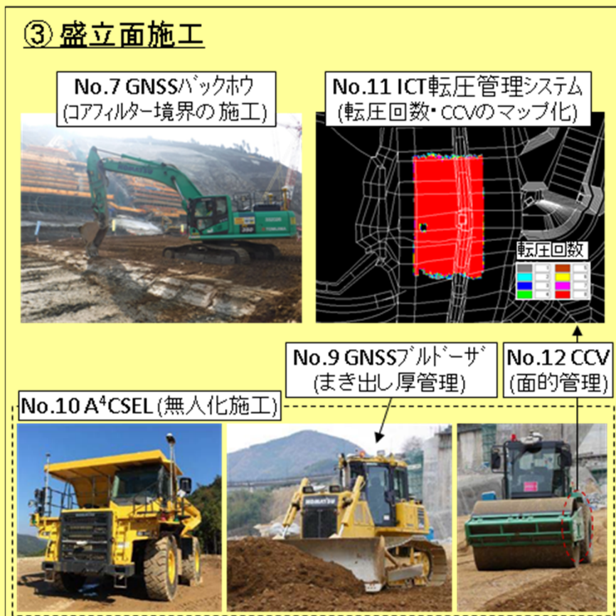
盛立工におけるICT施工の導入実績(盛立面施工)
