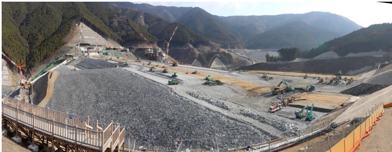
盛立工施工状況(高さ120m付近 H31.3撮影)
