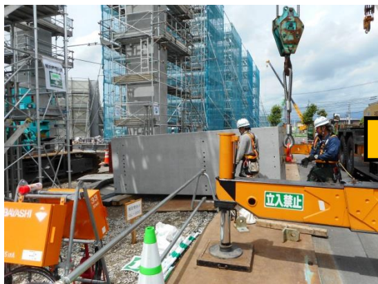
・ プレキャスト柱設置状況
