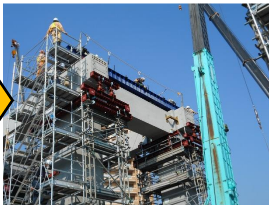
・ プレキャスト梁設置状況
