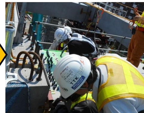
接合部モルタル 注入状況
