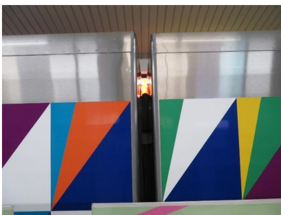
↑5-4号車間の隙間の状況
