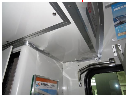
↑3号車1位側天井版変形
