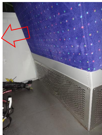
1号車4位クロスシート変形 (衝突側に傾き)
