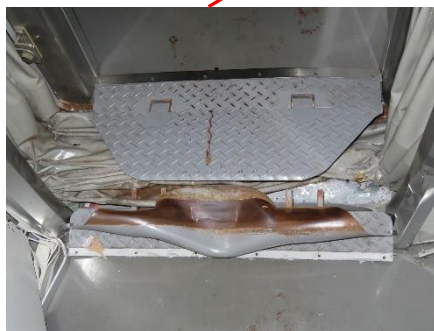
↑2-3号車間渡板変形 (付近の床板も大きく変形)
