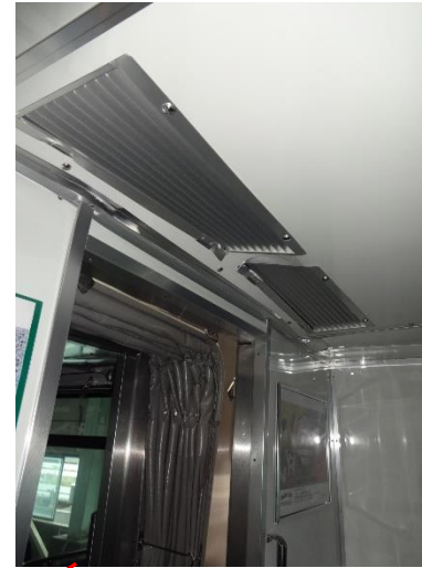
↓4号車3号寄り天井板変形
