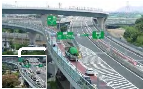
高速道路におけるピンポイント対策 (圏央道 海老名JCTの例)
