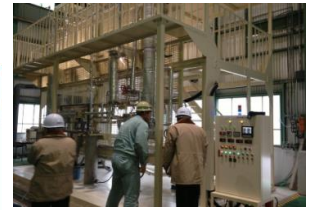
柏事業所に設置した基礎データ取得用試験機
