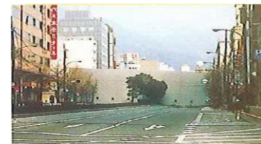
倒壊し避難路を塞いだ建築物
