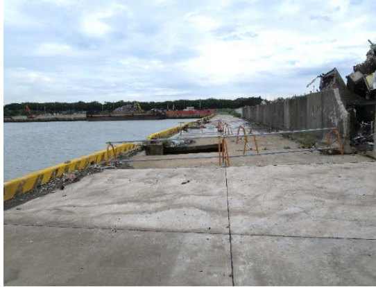
鋼矢板式岸壁
