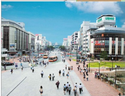
駅前のトランジットモール化と広場創出（兵庫県姫路市）
