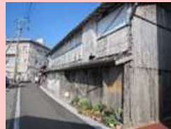
空き家の除却
