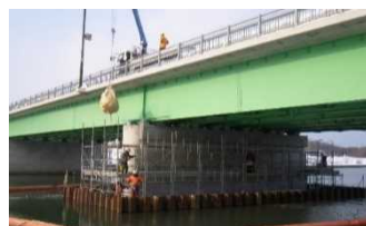
(緊急輸送路上の橋梁の耐震補強)
