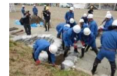
漏水対策工法(月の輪工)
