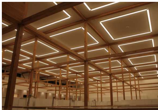
在来軸組工法 柱 3,600mm ピッチ
