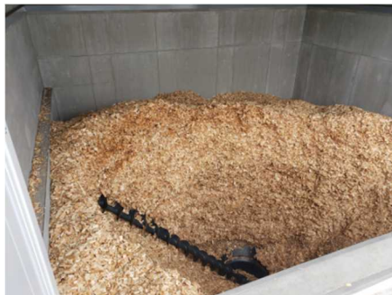
バイオマスボイラー棟・サイロ内部(2槽式)
