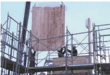
④ 町内業者による施工
