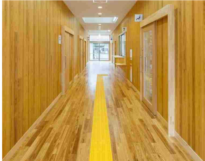
CLTを現しで使用した廊下
