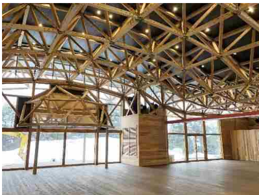
写真1 ホール棟内観
