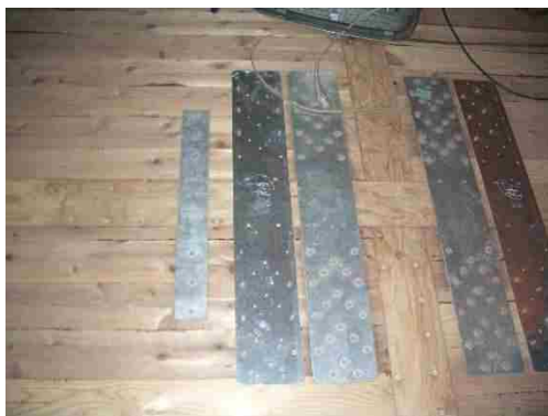
2階床面 CLT 金物取付状況（隠蔽前）
