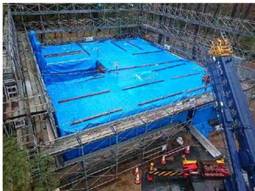
2階床雨対策養生
