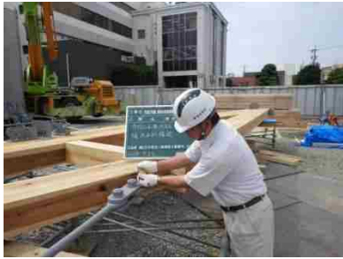
梁トラス地組み
