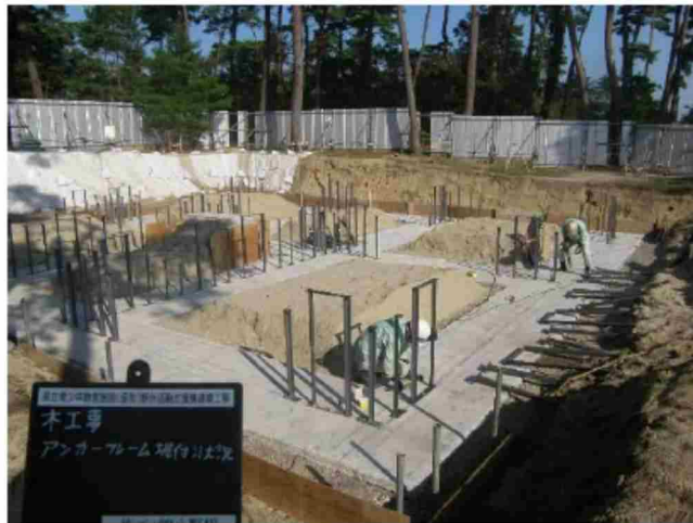
アンカーボルトセット用フレーム設置状況
