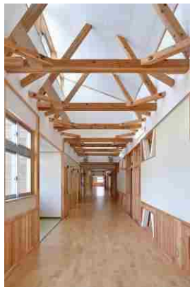
2階廊下の小屋組
