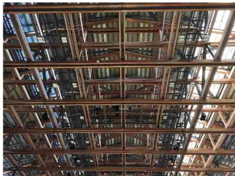
屋根架構状況
