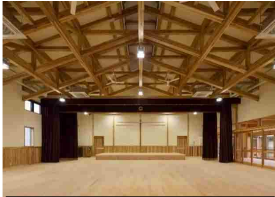
地域材を活用した集成材による遊戯室
