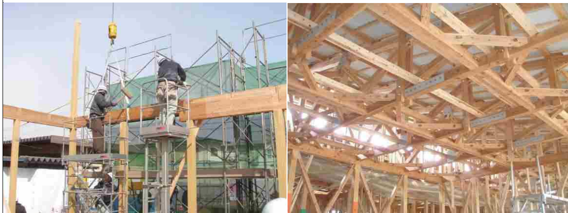
木構造建方状況
