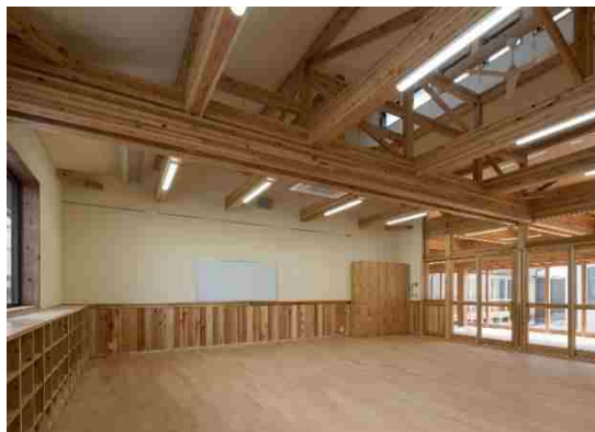
スギの腰板を使った保育室
