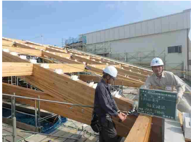
梁トラス架構作業
