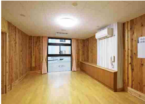
宿泊室 内観1 (壁面は極力CLT現し仕上げとしている)
