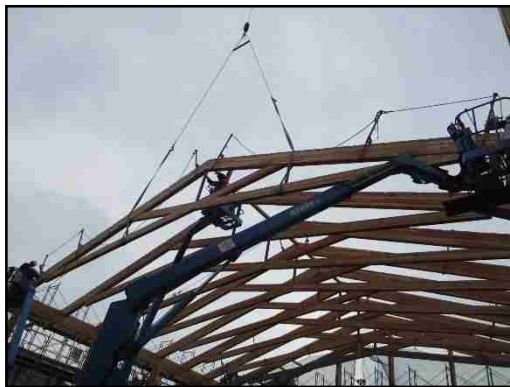
写真1 木造トラス地組み
