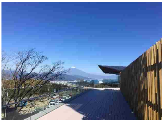
写真3 ブリッジ上部
