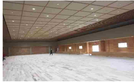
床材にスギ材を使用した剣道場
