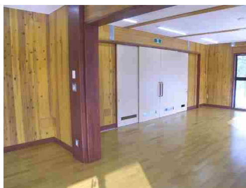
2階床面フローリング敷き（隠蔽後）
