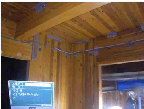
ケーブル取付状況（幕板隠蔽前）
