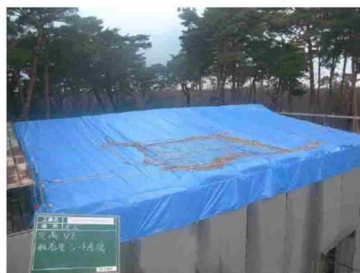
荒天対策養生
