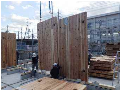
写真1 CLT建方状況写真
