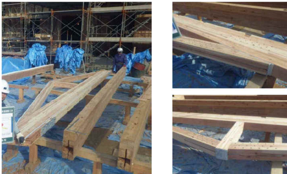
写真2 張弦梁の設計，地組と接合部
