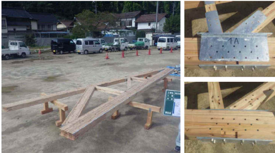
写真1 トラスの設計，地組と接合部
