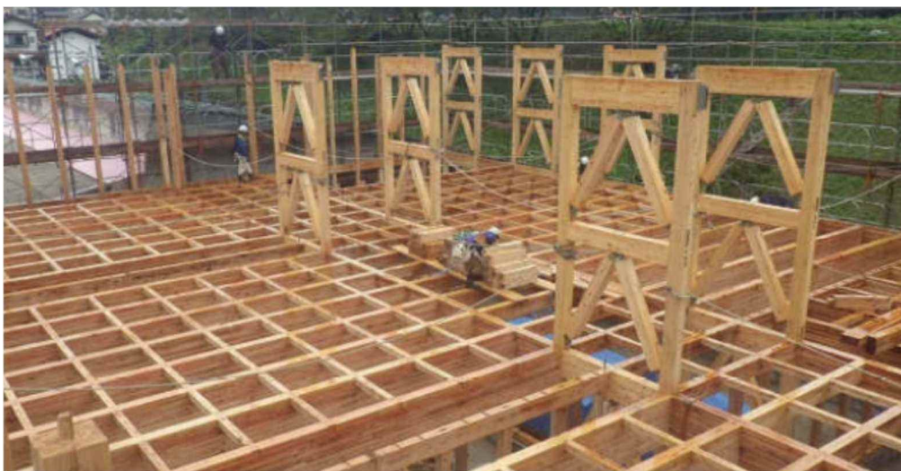
写真5 高耐力ブレースの建て方後
