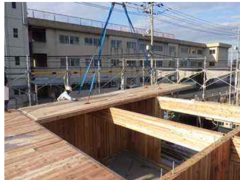
写真1 CLT建方状況写真
