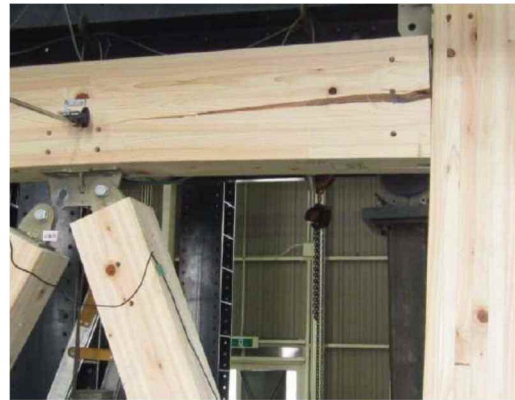
写真4 面内耐力実験の破壊性状
