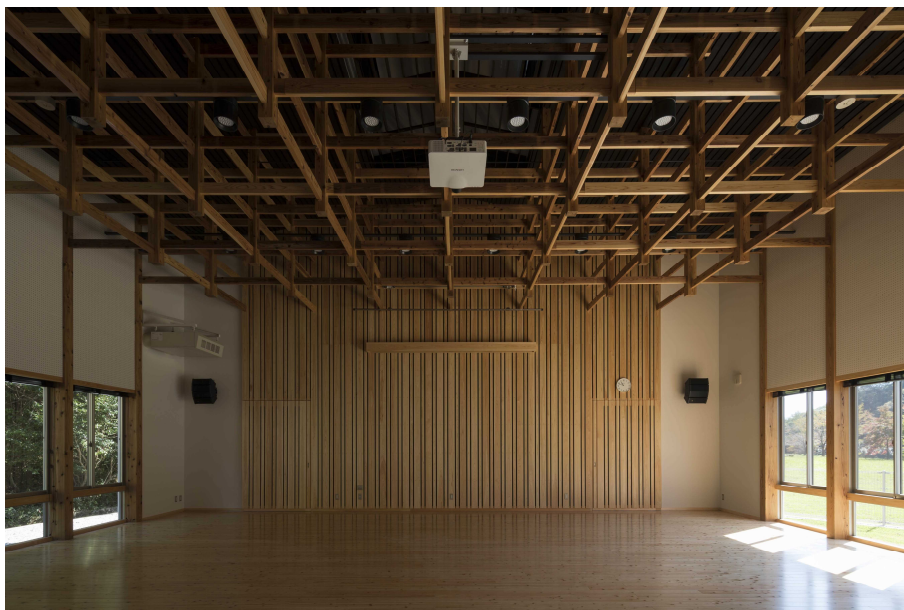
内観①：在来工法棟 1階多目的実習室
