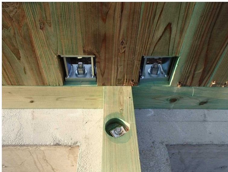
写真上：CLT建方、写真下：接合金物
