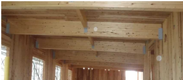
事務室集成材梁見上げ
