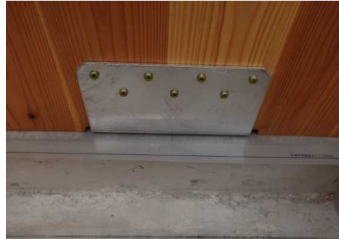
RC 立上り天端の防水・防虫シート
