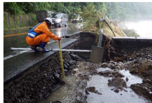
7月9日 被災状況踏査 (熊本県球磨村)
