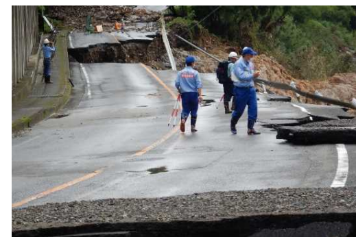
7月9日 被災状況踏査 (熊本県球磨村)
