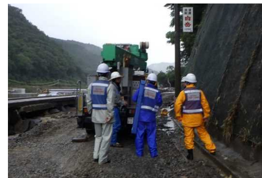
7月9日 道路啓開の事前調査 (熊本県球磨村)
