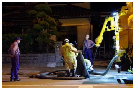
7月9日 側溝清掃車で粉塵除去 (熊本県人吉市)
