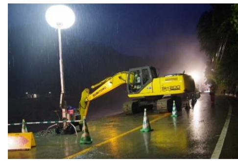
地元建設業者とともに国道219号を24時間体制で道路啓開(熊本県球磨村) 対象延長 約43kmのうち約17km(約40%)の道路啓開完了(7月11日時点)
