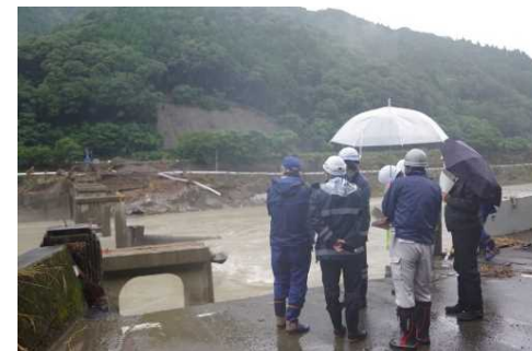
7月10日 道路啓開のための現地調査 (熊本県球磨村)
