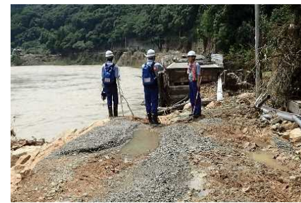
7月12日 被災箇所の現地調査 (熊本県八代市)
