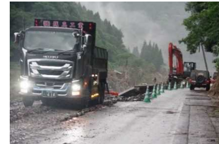
7月14日 調査結果に基づいた道路啓開 (熊本県球磨村)
