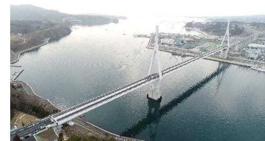
三陸沿岸道路 気仙沼港～唐桑半島 気仙沼湾横断橋
