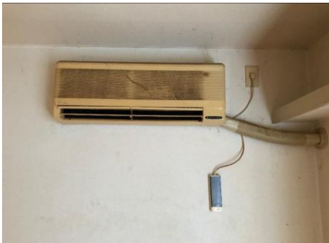
【写真E 施工前】
