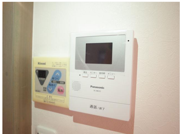
【写真 F 施工後】
