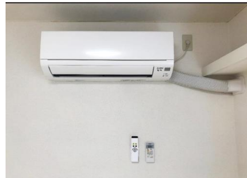
【写真F 施工後】
