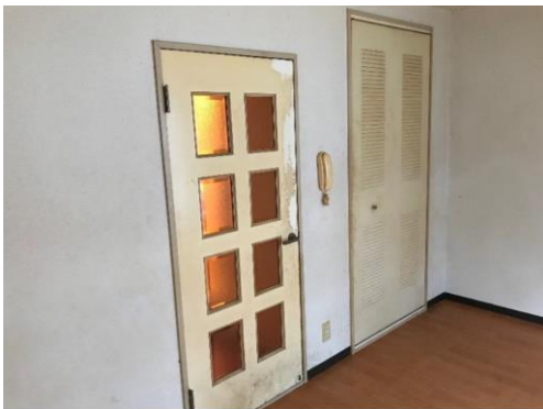
【写真C 施工前】
