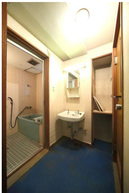
【写真 A 施工前】
