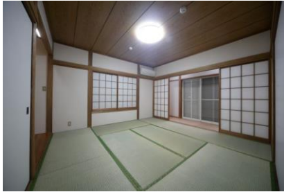
【写真 A 施工前】
