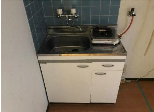
【写真A 施工前】
