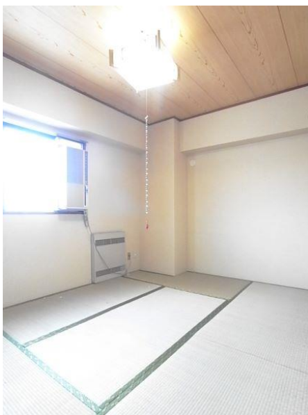
【写真 C 施工前】
