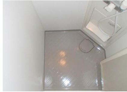
【写真B(上) 写真C(下) 施工後】
