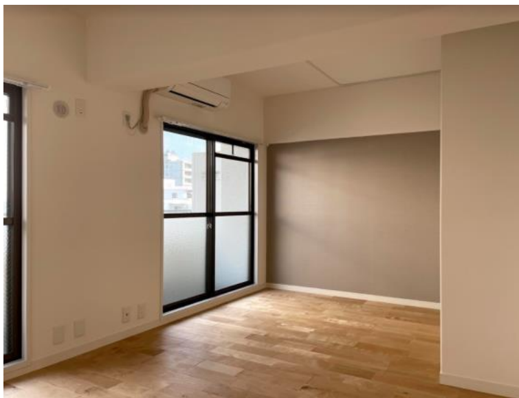
【写真B 施工後】
