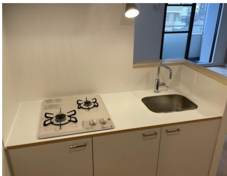
【写真D 施工後】
