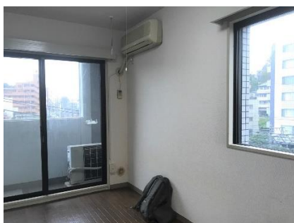
【写真 A 施工前】
