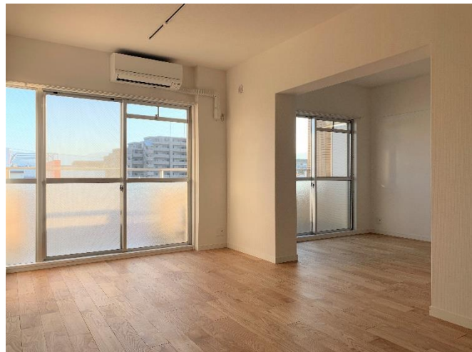
【写真 B 施工後】
