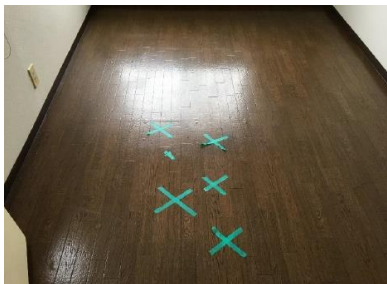
【写真F 施工前】
