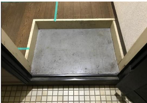
【写真E 施工前】
