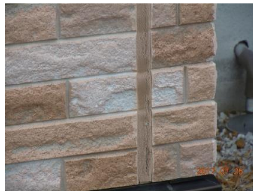
(シーリング材のひび割れ)
