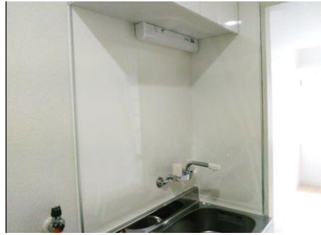
【写真C（上）写真D（下） 施工後】
