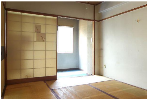
【写真 G 施工前】
