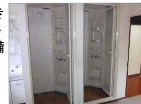
シェアハウスの改修
