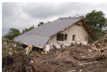
土石流による被災(伊豆大島)
