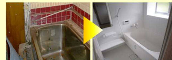
空き家（内装）改修前後
