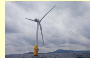
福江島の沖合の浮体式洋上風力発電所
