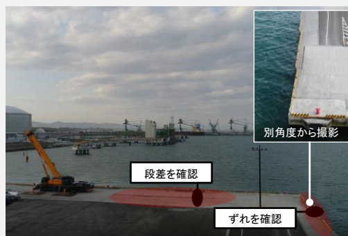
通常の岸壁の調査状況 (段差や護岸法線のずれ等を確認)
