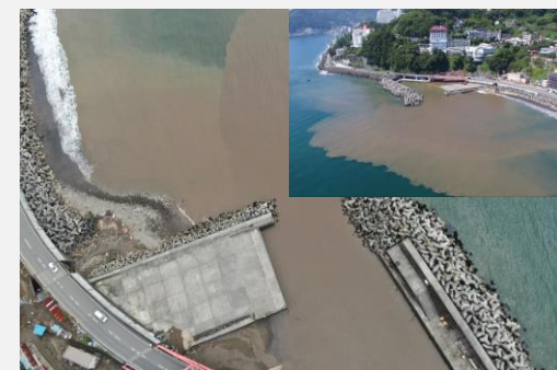
熱海港伊豆山地区の調査状況
