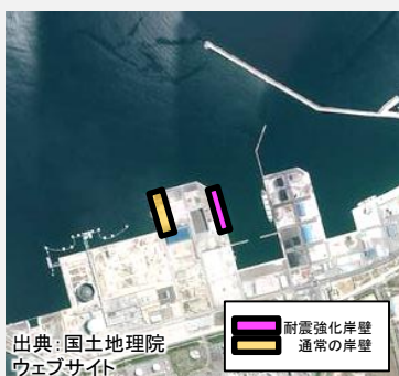
ドローン調査実施箇所
