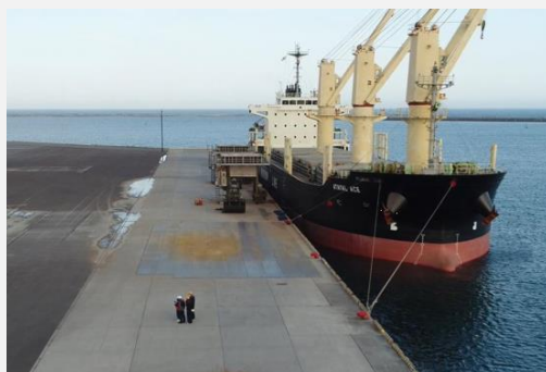
耐震強化岸壁の調査状況 (被害確認されず)
