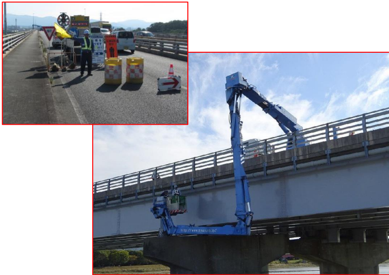
通行規制を実施し、橋梁点検車で近接目視点検
