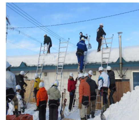
雪下ろし実技講習
