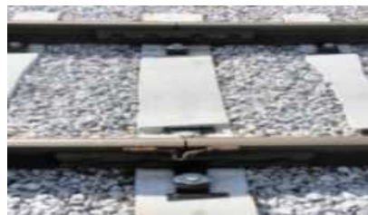
【コンクリート枕木(軌道改良)】
