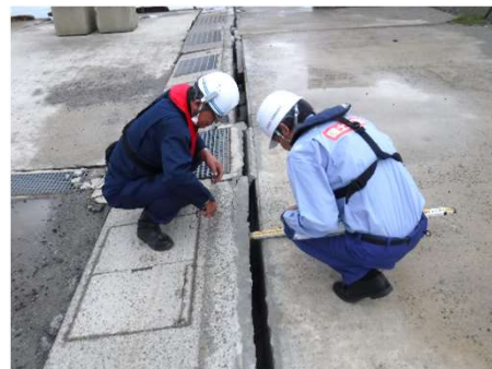
飯田港の被災状況調査(珠洲市)
