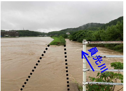
②員光川の堤防決壊（応急復旧中）
