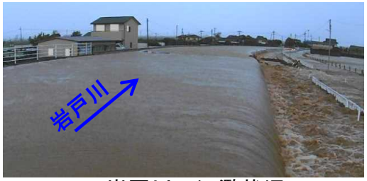
岩戸川の氾濫状況
