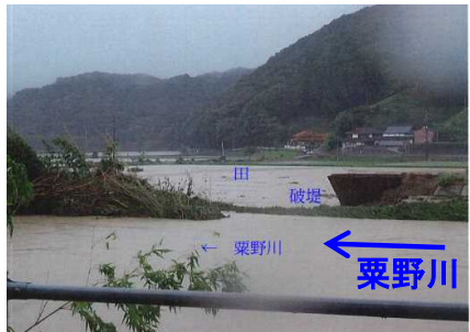
①粟野川の堤防決壊（応急復旧完了）
