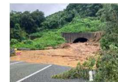
高山トンネル東坑口
