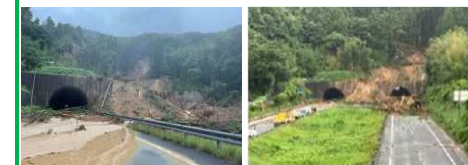
高山トンネル西坑口
