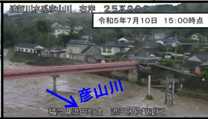
彦山川 福岡県添田町 添田水位観測所 (護岸の崩落)
