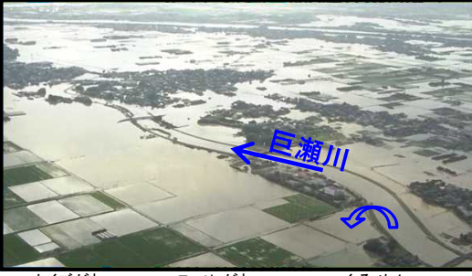
ちくごがわ こせがわ くるめし 筑後川水系巨瀬川(福岡県久留米市) (家屋浸水あり)
