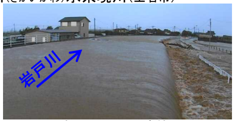
岩戸川の氾濫状況
