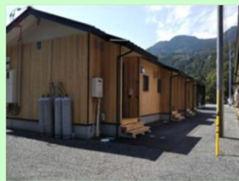
木造仮設住宅（設置例）
