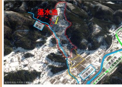
②石川県輪島市市ノ瀬町
