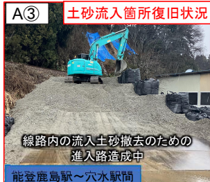
線路内の流入土砂撤去のための進入路造成中
