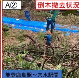
能登鹿島駅～穴水駅間
