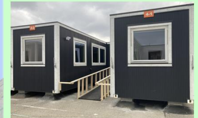
ムービングハウス（輪島市完成例）
