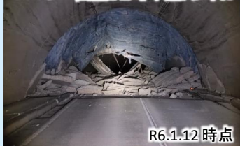
写真① 国道249号中屋トンネル
