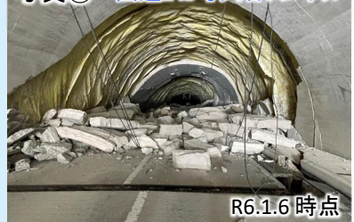
写真⑤ 国道249号大谷トンネル
