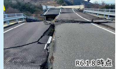
写真④ 国道249号鳥川橋
