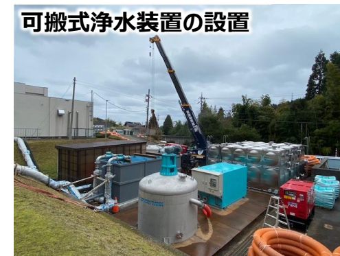
宝立浄水場可搬式浄水装置
