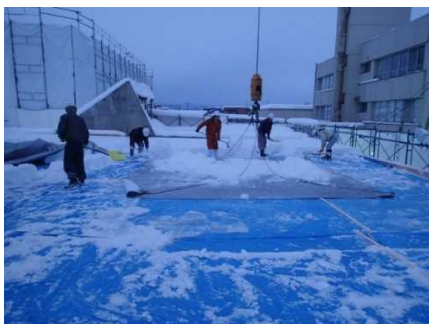
写真-3 除雪状況(その 1)
