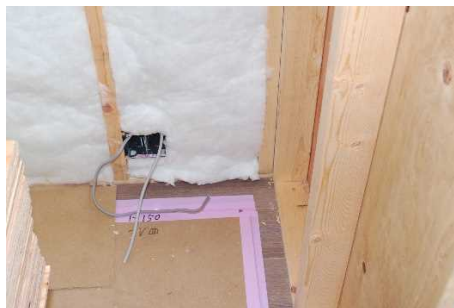
写真-3 断熱材の充填状況(その2)※2
