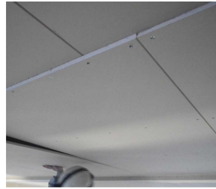
写真-2 天井部の強化せっこうボードの施工の例
