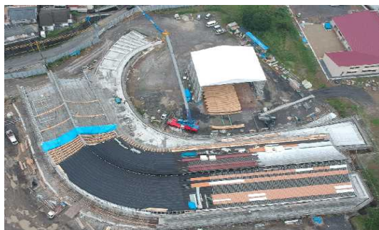
写真-9 素屋根地組ヤードの例
