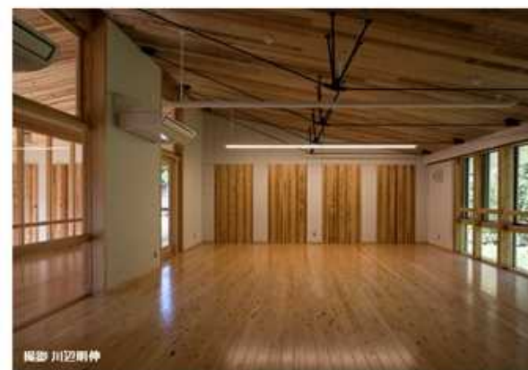
CLTを使用した教室
