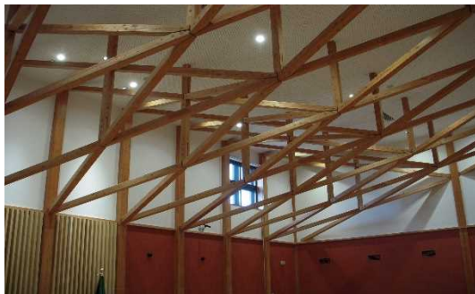
写真-1 流通小径製材による架構の例
