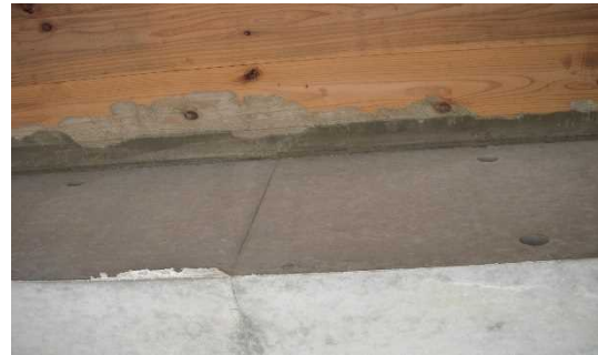
写真-8 同左コンクリート打設確認の例
