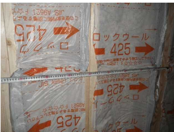
写真-1 断熱材の施工状況
