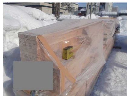
写真-9 積雪時の養生の例
