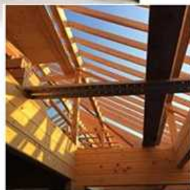
小屋組の状況（工事中）
