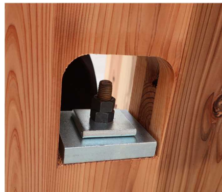
写真-7 引抜きボルトの開口部の例
