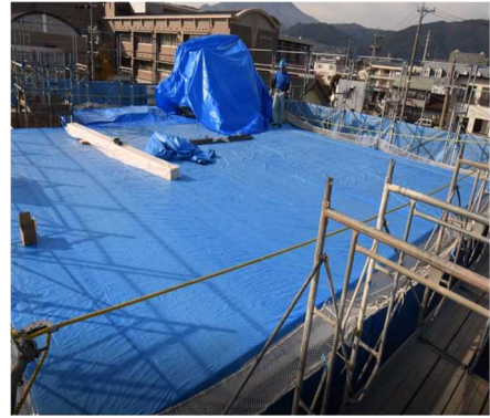
写真-3 床の養生の例
