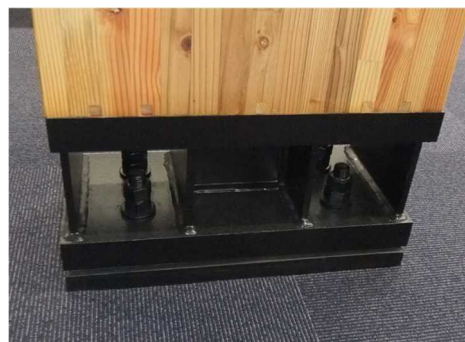
写真-9 接合部を露出させた例(柱脚部)
