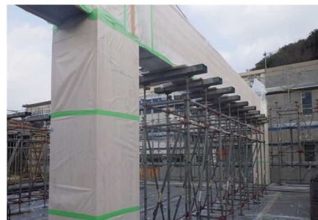
写真-7 仮設受材の養生例 (仮設受材の間隔は、構造計算により決定・受材上部にはクッション材を設置)
