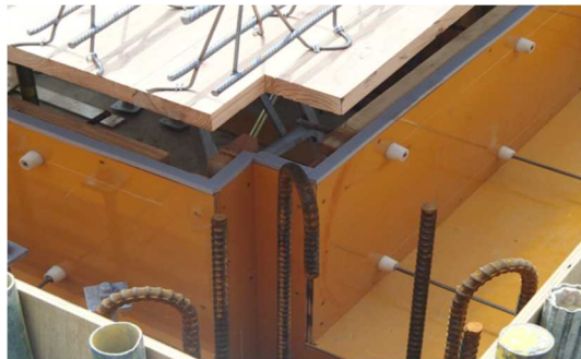
写真-7 CLT床版と梁取合い (ノロ止め)モックアップの例
