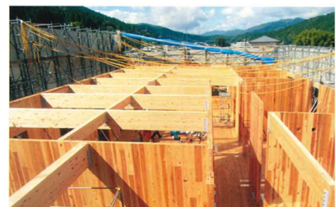
写真 6-2 建方時シートをたたんだ状態の例
