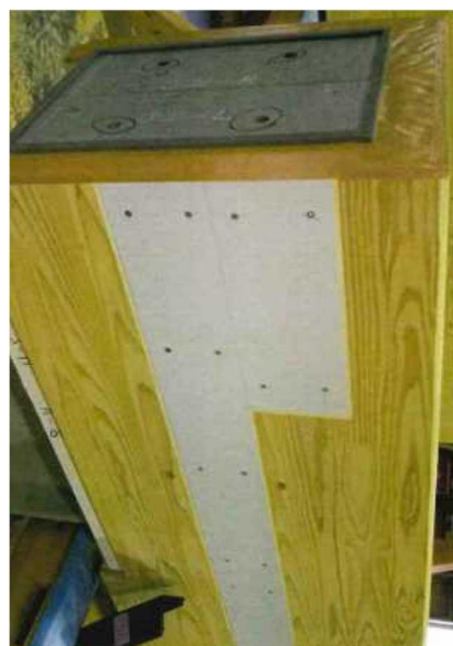
写真-1 防火区間の取合い部に張り付けられたケイカル板(燃え止まり型)の例 (写真上部はシャッターケースとの取合いのため大きくなっている。)
