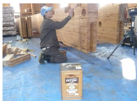
写真-1 製作工場での汚染防止剤の塗布の例
