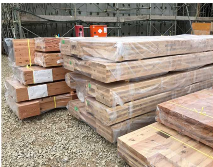
写真-3 工事現場での集積状況の例
