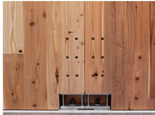
写真-6 X(クロスマーク)表示引張金物を使用した例
