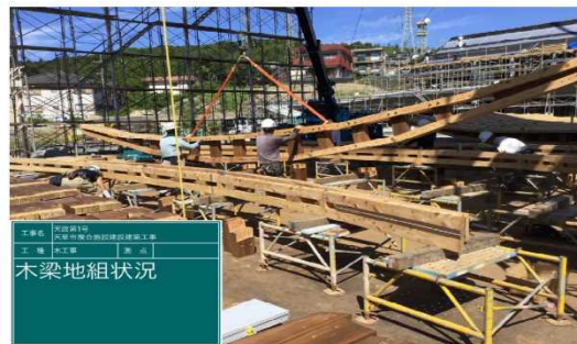
写真-10 重ね透かし梁の地組の例
