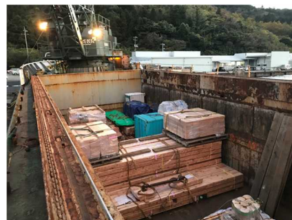
写真-11 連絡船による海上運搬の例
