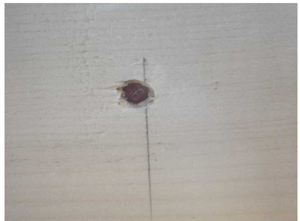
写真-1 釘打ち機のエア圧を調整するための打ち込み状況確認例
