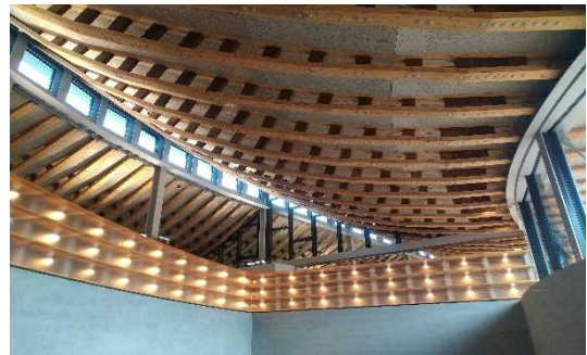
写真-4 重ね透かし梁材による曲線架構の例
