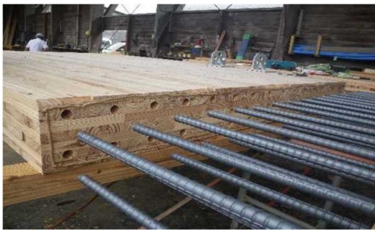
写真-11 CLT への鉄筋挿入の例
