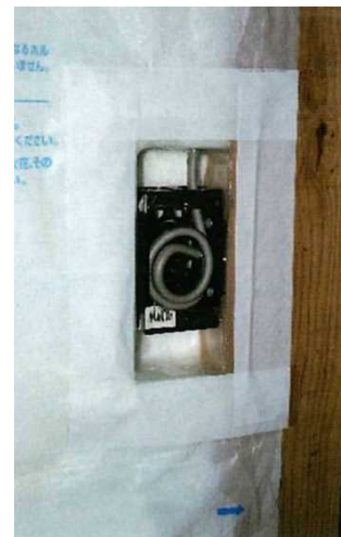
写真-4 気密テープの施工状況※1
