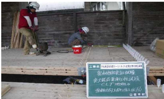
写真-13 CLT の鉄筋エポキシ樹脂注入の例
