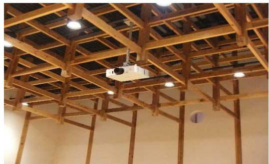
写真-2 伝統工法による架構の例
