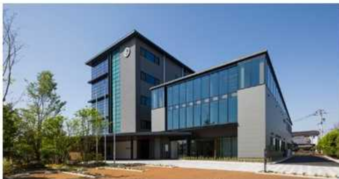
外観 左：事務所棟 右：会議室棟
