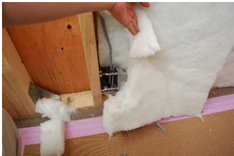
写真-2 断熱材の充填状況(その1)※2
