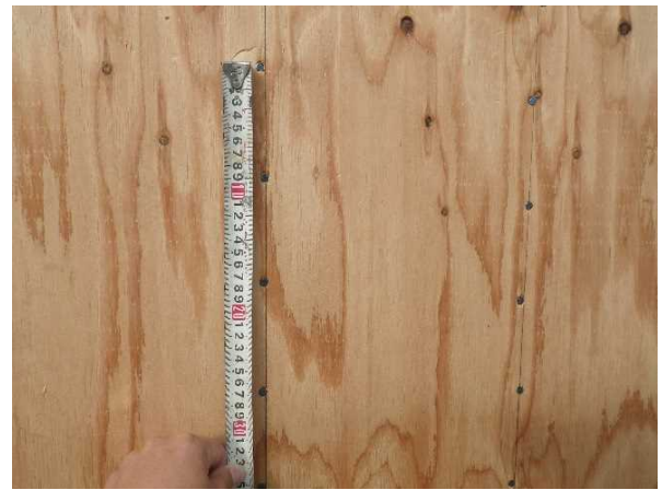
写真-2 間柱の芯が分かるようガイドが引かれている状況の例
