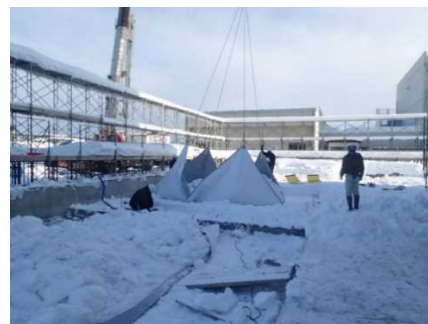
写真-4 除雪状況(その 2)
