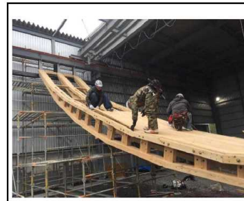
写真-6 重ね透かし梁モックアップ製作の例
