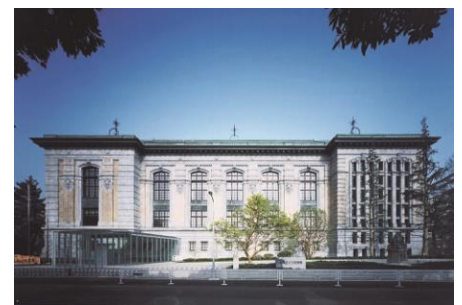
国際子ども図書館(1906建築、2001改修・増築、2015増築)
