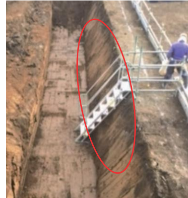
IoT建築土工を活用した施工
