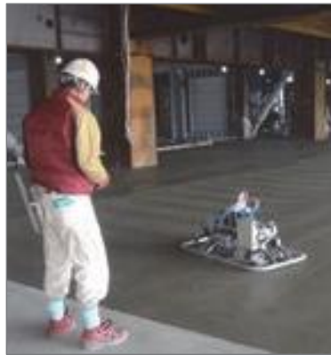
施工合理化技術の導入促進(ex.コンクリート床仕上げロボット)
