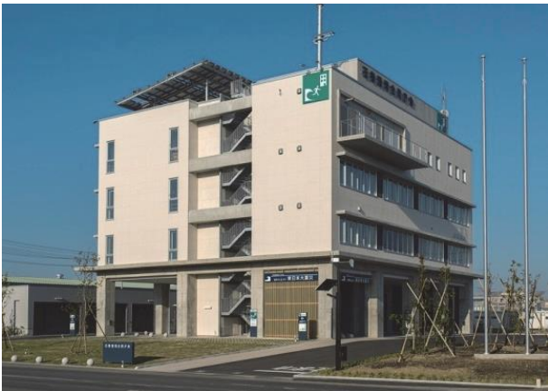
▲ 津波発生時の災害応急対策活動と津波避難ビルの機能を確保した石巻港湾合同庁舎
