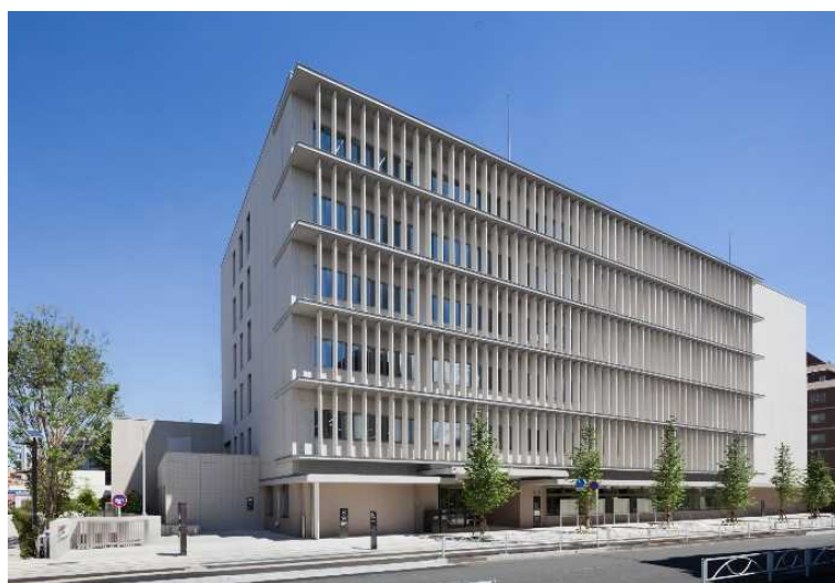
図3-3: 地域と連携した官庁施設整備の事例(世田谷合同庁舎)
