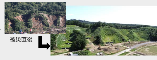
大規模山腹崩壊からの復旧（厚真町）
