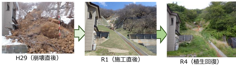
H29（崩壊直後） R1（施工直後） R4（植生回復） 山腹崩壊した斜面に山腹工を施し、その後、植生が回復してきている様子↑（神恵内村）
