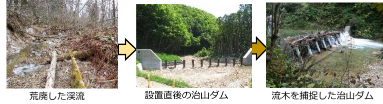
荒廃した溪流 設置直後の治山ダム 流木を捕捉した治山ダム 流木捕捉機能を持った治山ダムの効果（イメージ）↑ （左：荒廃し流木が発生した溪流（釧路市）、中：そのような場所に設置された流木捕捉式治山ダム（奥尻町）、右：治山ダムが流木を捕捉している様子（函館市））
