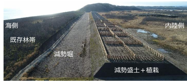
飛砂や風害等の防止に加え、津波被害軽減効果も期待される海岸防災林（釧路市）
