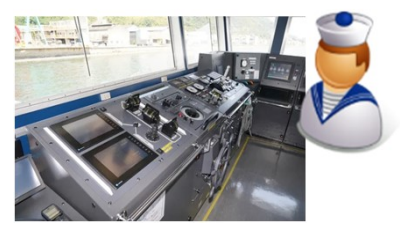
集中荷役遠隔システム
