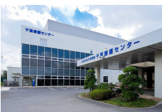
老朽化の進む千葉療護センター(築38年)
