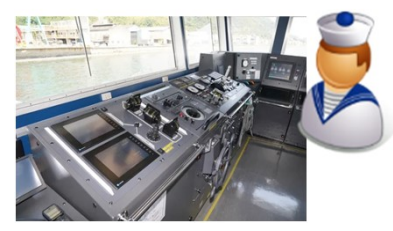
集中荷役遠隔システム
