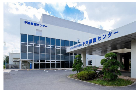
老朽化の進む千葉療護センター(築39年)
