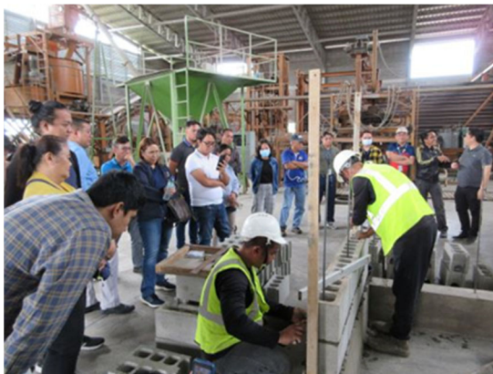
ブロック積デモンストレーション
