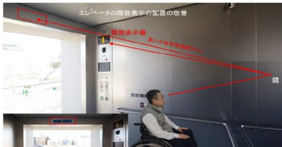
エレベーター階数表示の配置の改善 ・車椅子使用者の鏡に反射する視線と、階数表示器の見やすさの検証を行い、側面の表示器以外に扉上部に階数表示器を追加
