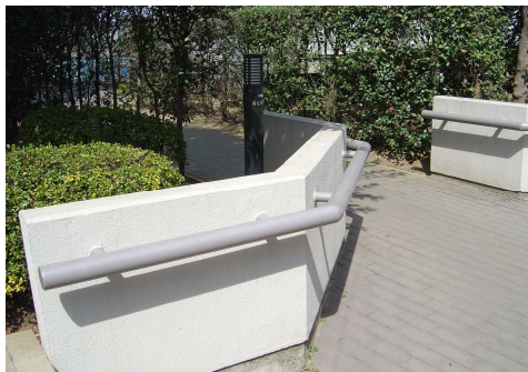
敷地内の手すりの設置
