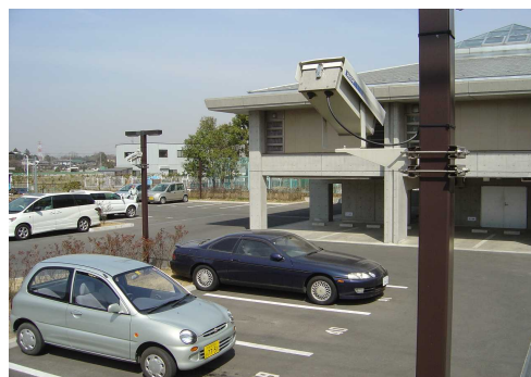
住棟から離れた駐車場への防犯カメラの設置
