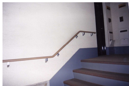
共用階段への手すり設置
