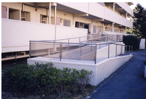
1階共用外廊下へのスロープ設置
