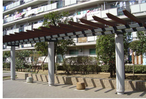
パーゴラ・ベンチの設置
