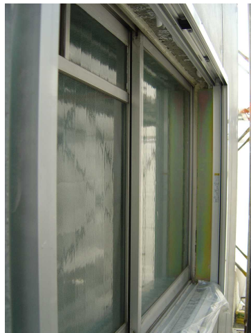
外付け工法による窓サッシの2重化
