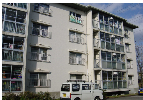
バルコニーの屋内化(上)(右) サンルーム的な利用が期待できる。
