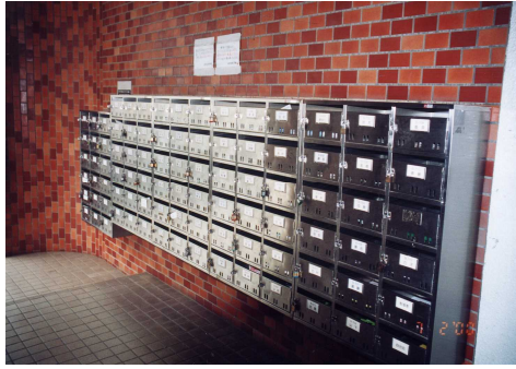
集合郵便受けのグレードアップ(スチール製からステンレス製・全戸ダイヤル式鍵付きタイプへ)
