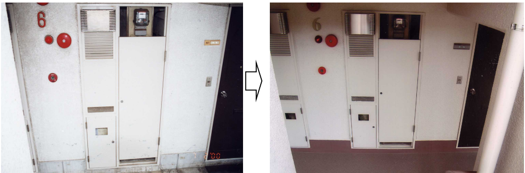
パイプスペース扉のグレードアップ
