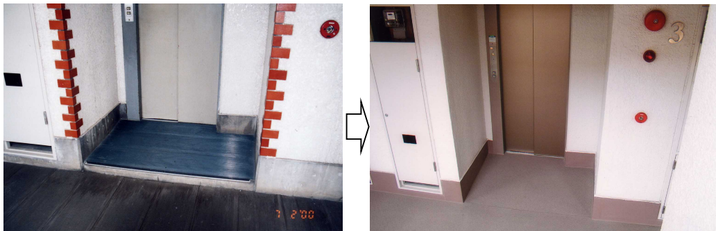
エレベーター出入り口の段差の擦り付け
