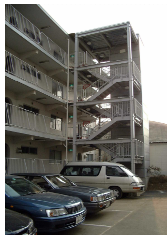
既存外廊下に着床したEV棟・外階段と一体化している
