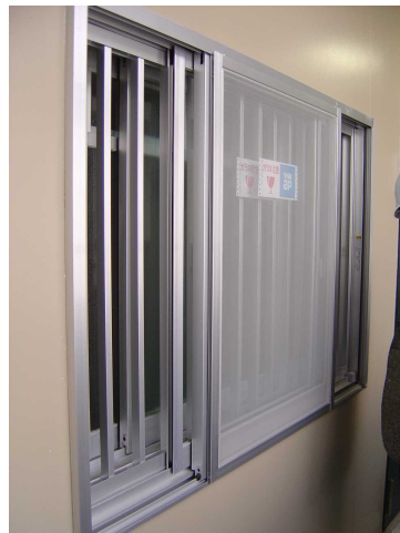
非常時脱出機能付き面格子の設置
