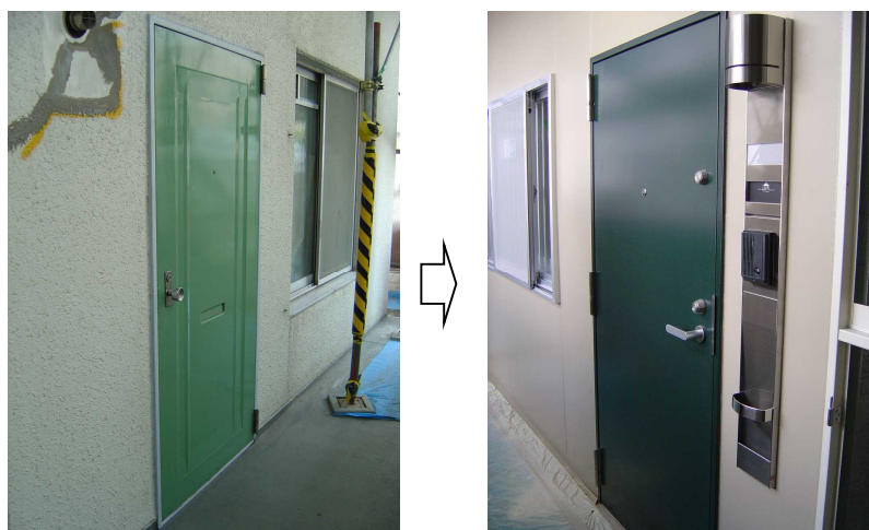
ドアの取替えにあわせた住戸ドア周りのグレードアップ(門灯、室名札、インターホン、新聞受けホルダーが一体となった玄関ドア脇パネルの新設)
