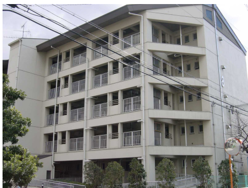
増築部分を北側から見たところ
