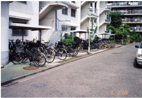
住棟前歩道の舗装のグレードアップ(歩道の拡幅及びインターロッキング舗装)
