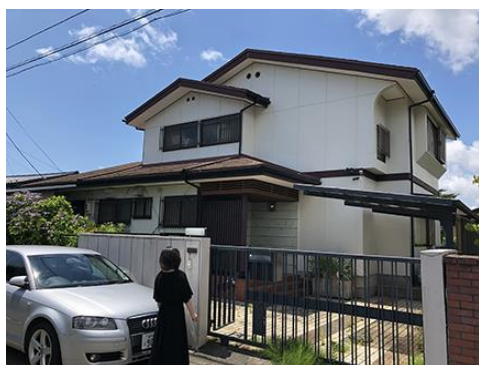
写真9 協議した空き家予備群
