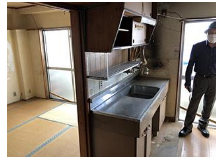
写真 13 同建物 2階住居部分
