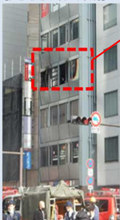
【火災建築物 外観】
