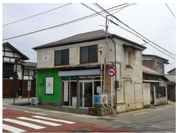
写真1：利活用された旧店舗併用住宅
