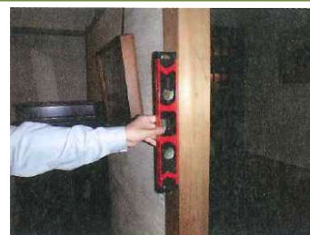
水平器による 柱の傾きの計測
