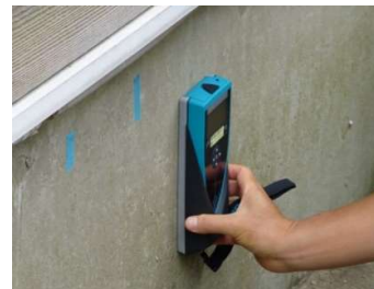
基礎配筋の調査
