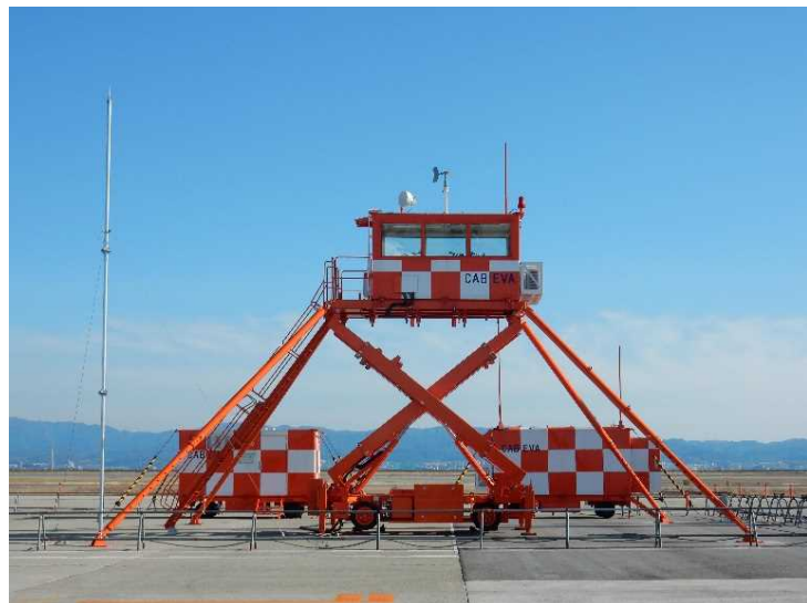
非常用管制塔装置
